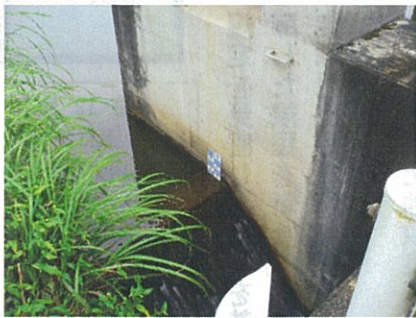
改修された水位標識
