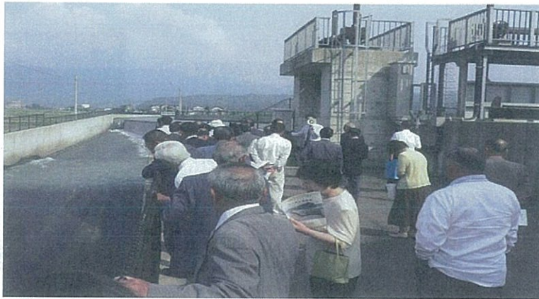
手取川七ヶ用水土地改良区では、かんがい用水を利用して小水力発電を行っています。最大出力630kwを発電し、年間千円の純利益を出しています。
