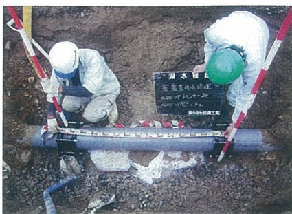
漏水箇所補修状況
