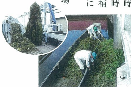
流草群除去作業状況
