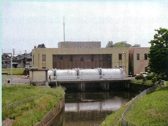
全景（国道160号沿い仏生寺川右岸）
