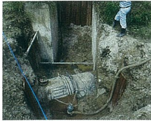
漏水補修状況
