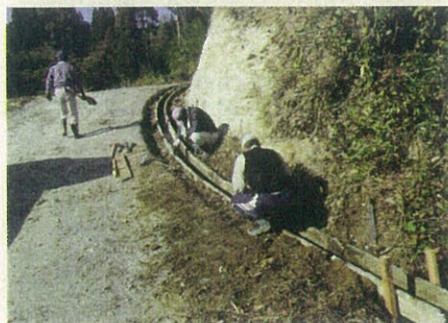
水路簡易補修
