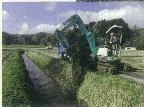
水路の泥上げ
