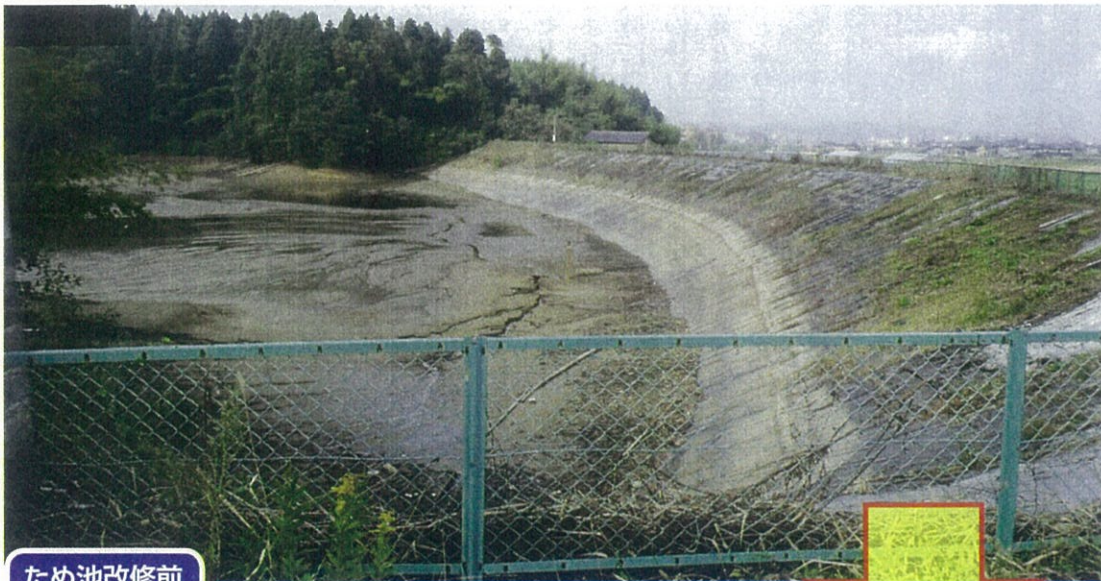
ため池改修前
