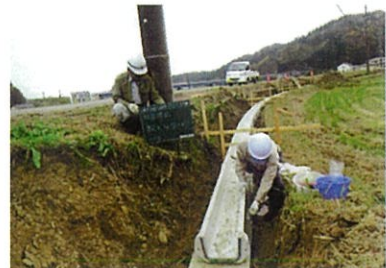
フリュームの設置と調整をしています
