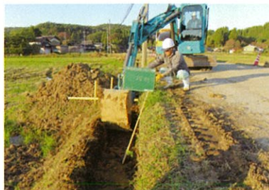
重機を操作し掘削しています
