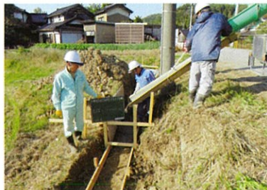
コンクリートを打設しています
