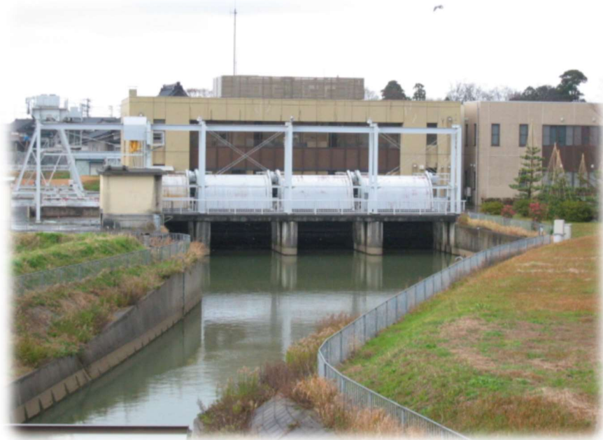
24時間365日体制で氷見市民を浸水被害から守る十二町瀉排水機場
