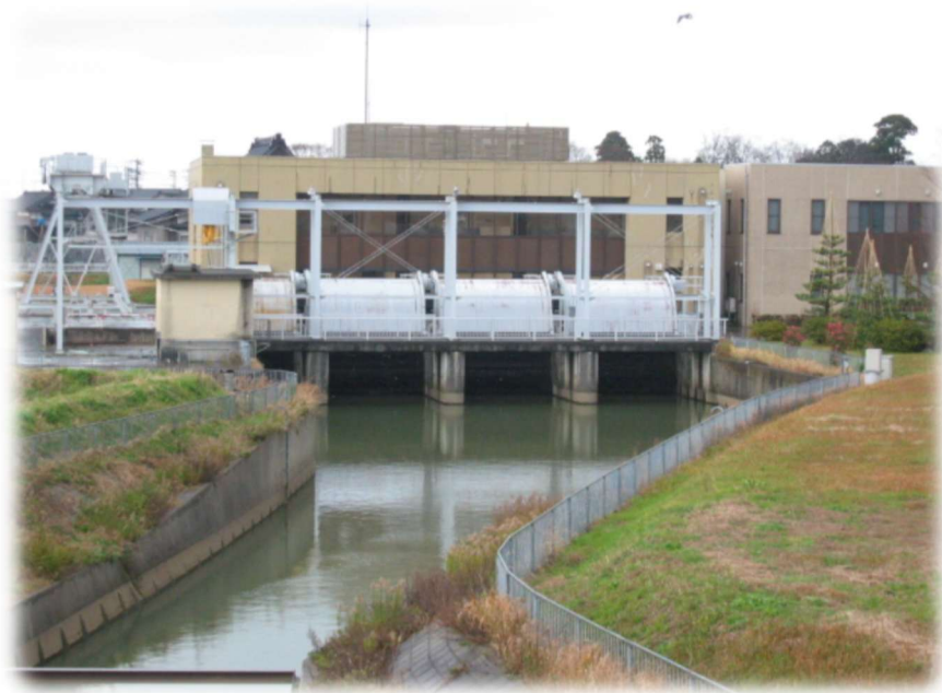
24時間365日体制で氷見市民を浸水被害から守る十二町潟排水機場
